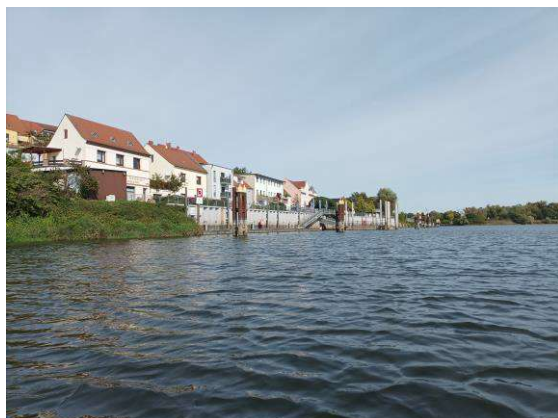
Bollwerk in Eisenhüttenstadt
