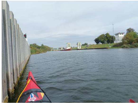
Blick auf Schleuse Hohensaaten West
